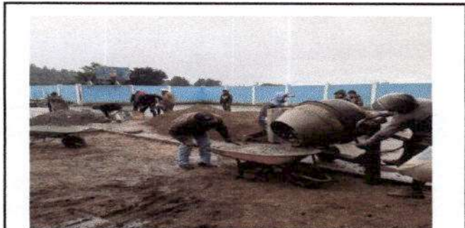
Foto 6: Colocación de torta de cemento patio.
