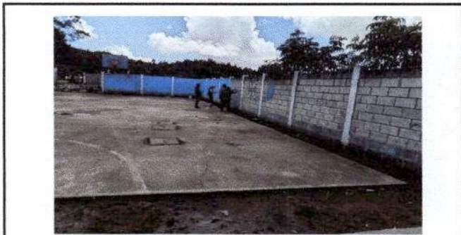
Foto 3: Pintando el área de muro de contención.
