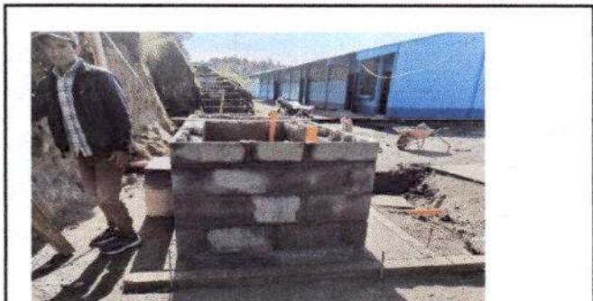
Foto 4: Reconstrucción de pila de dos lavaderos.
