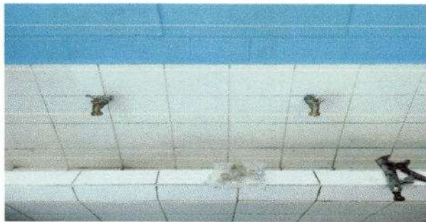
Foto 5: Colocación de chorros nuevos.
