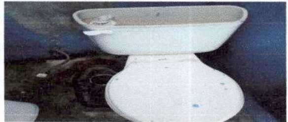
Foto 4: Quitando los inodoros en mal estado.
