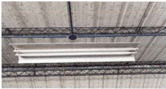
Foto 3: Quitando focos en mal estado.
