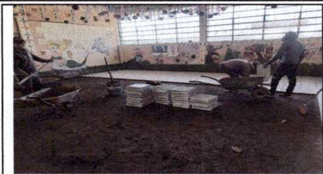
Foto 2: Pegando piso de granito en las aulas.
