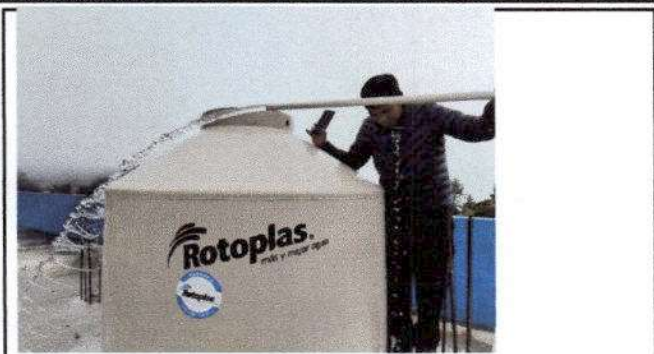
Foto1: Colocación de deposito de agua.
